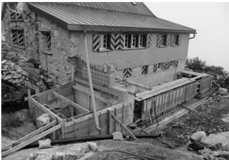
Schmelz- und Regenwasser. Die Felspartien wurden mit einigen Sprengungen beseitigt. Wo man doch eher steinigen und felsigen Boden vermutet hatte, stand man beim Aushub für den Frostriegel plötzlich vor moorähnlichem Untergrund, der ausgebaggert werden musste, um ein gutes Fundament zu erhalten.
